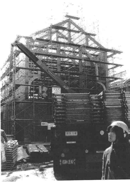
多目的ホール工事中
